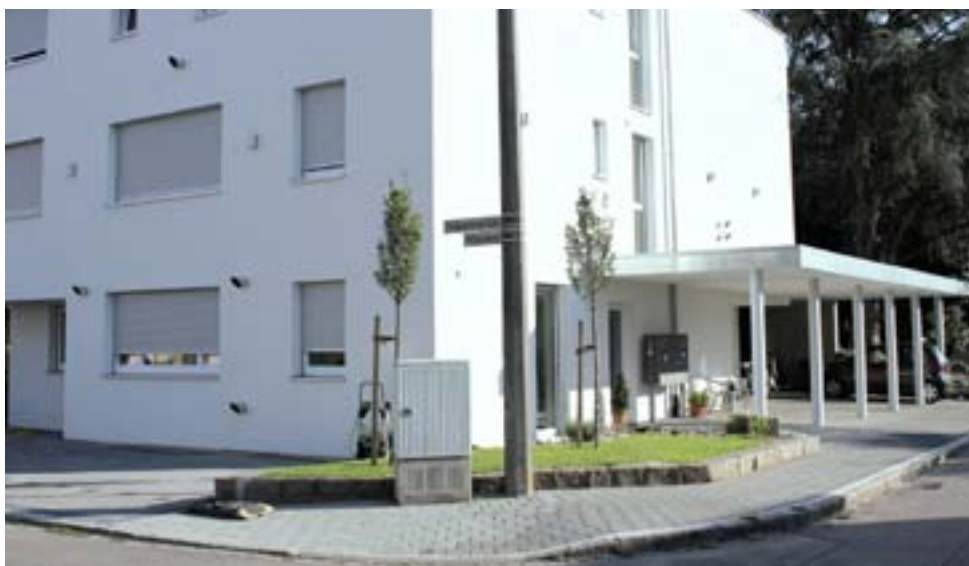
Der 550 Quadratmeter große Neubau unterschreitet deutlich den Passivhausstandard.
